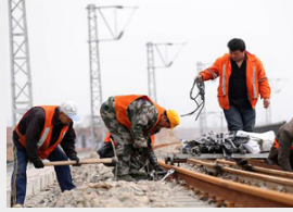
黄韩侯铁路侯西段电气化复线施工进展顺利
